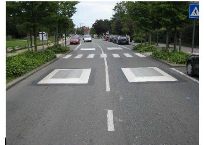
Figuur 1: Rijbaankussens [Stroobantsstraat, Evere]
